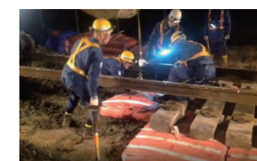
■写真8 路床へのD・Box 敷設状況
