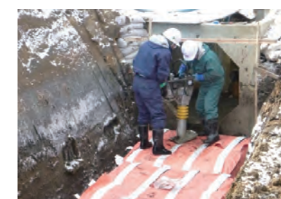
⑧D・Box転圧状況
