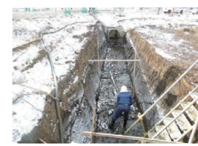
⑥管渠掘削状況
