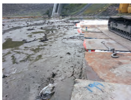
■写真14 仮設道路(近景)
