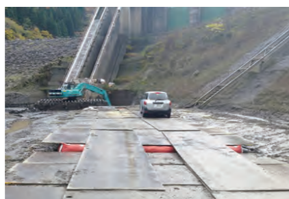
■図15 仮設道路(遠景)
