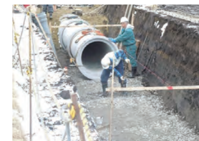
⑩管渠設置状況
