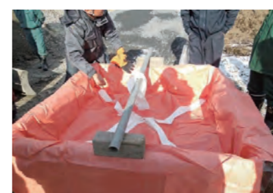
②D・Box型枠設置
