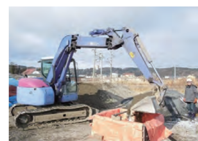
③中詰砕石(RC40)投入
