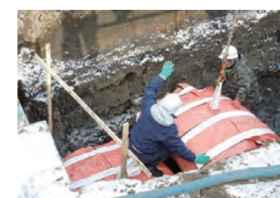
⑦D・Box敷設状況
