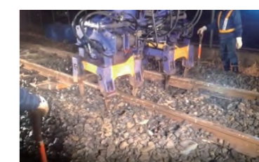
■写真9 パラスト締固、復旧状況
