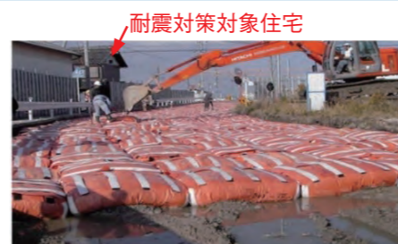
■写真4 D・Box 敷設状況(下層路盤)
