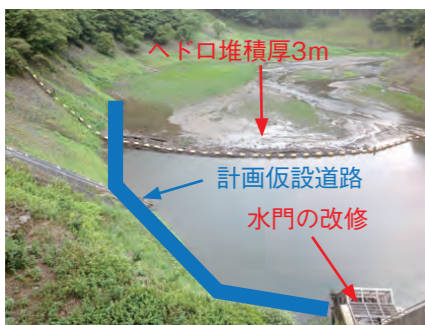
■写真13 ダム湖底のヘドロ状況と仮設道路
