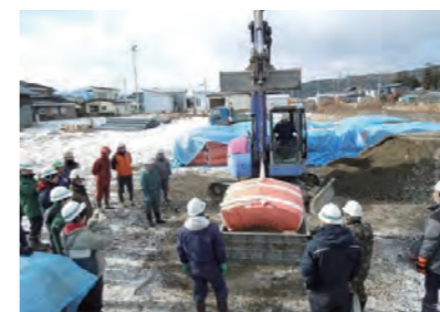
⑤D・Box吊上状況
