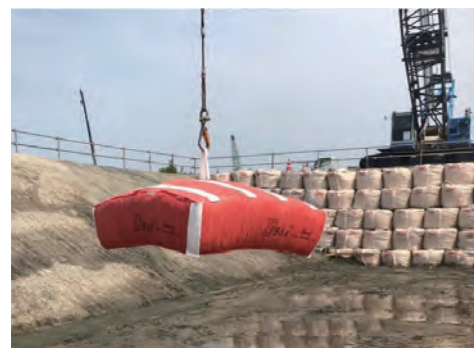
■写真2 D・Box の吊上げ状況
