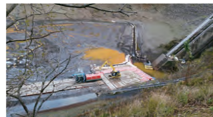
■写真16 仮設道路とクレーン作業足場
