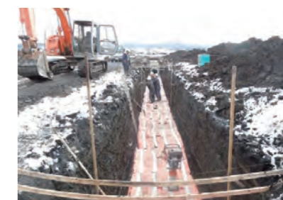
⑨D・Box敷設・転圧完了
