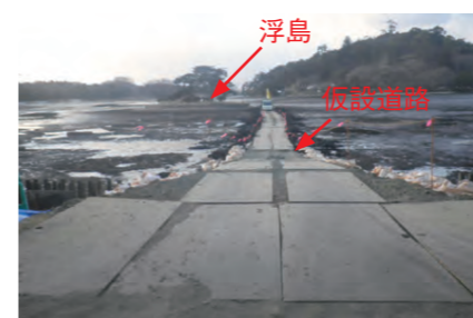
■写真19 仮設道路完成状況
