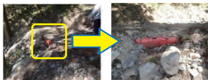
■写真12 豪雨時の滝による浸食対策例
