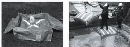
(a) 上面を開けた状態 (b) 設置状況 写真-5 開封時のD・Box-LSと設置状況
