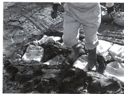
写真-1 軟弱地盤での土のうの様子
