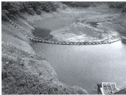
写真－6 施工前の現場状況（手前が水門）
