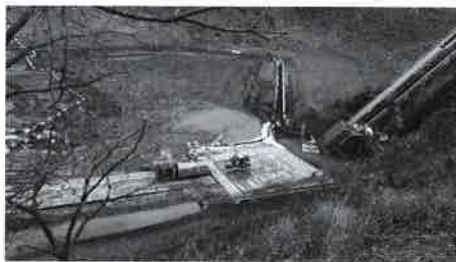
写真-7 D・Boxの施工状況
