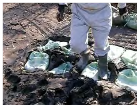
写真-3：軟弱地盤での土のうの様子
