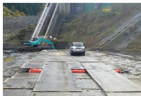
写真-7：①～④の作業状況
