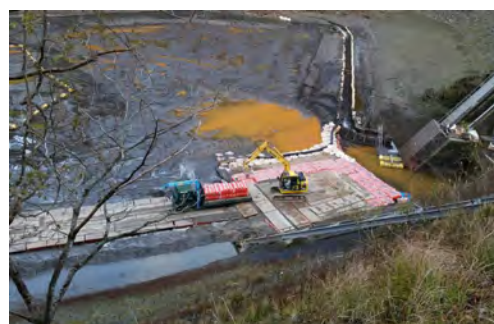
写真-8：仮設道路と作業ヤードの状況
