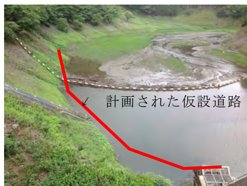
写真-6：現場状況
