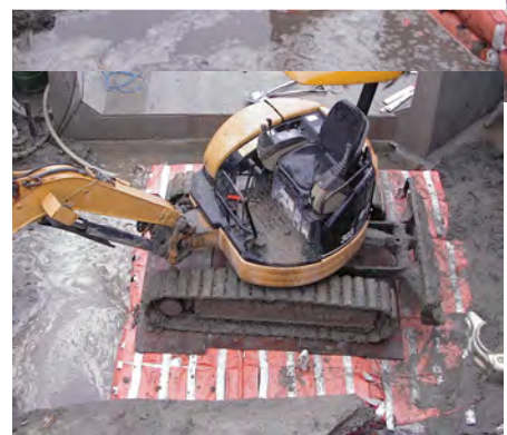
写真-11 : D・Box 敷設の状況
