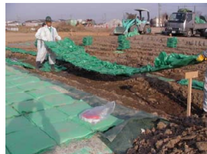
図-11 D・BOX-SS45の作業状況
