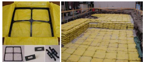
(a) 使用されるパーツ (b) 設置例 図-1 D・BOX-SS45 と設置状況
