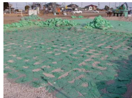
図-12 D・BOX-SS45の敷設状況
