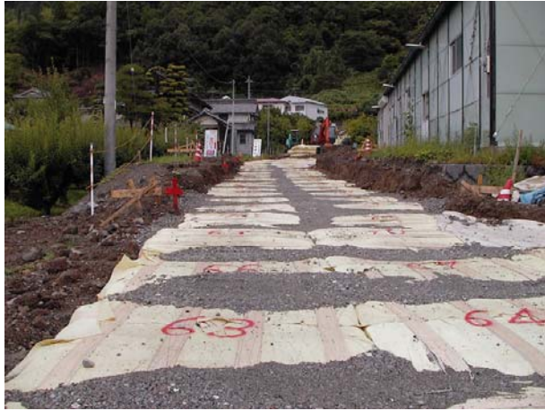
図-18 D・BOX工法 (LS150) の施工状況
