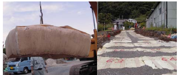
(a) 吊上げ状況 (b) 設置例 図-2 D・BOX-LS150 と設置状況
