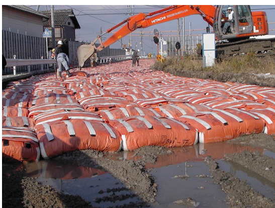
図-17 D・BOXの敷設状況
