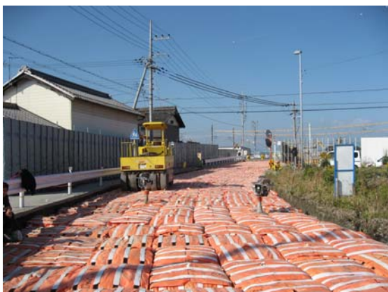
図-18 D・BOX敷設後の転圧状況
