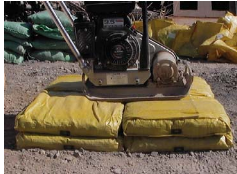
図-14 ジョイントで連結されたD・BOX-SS45
