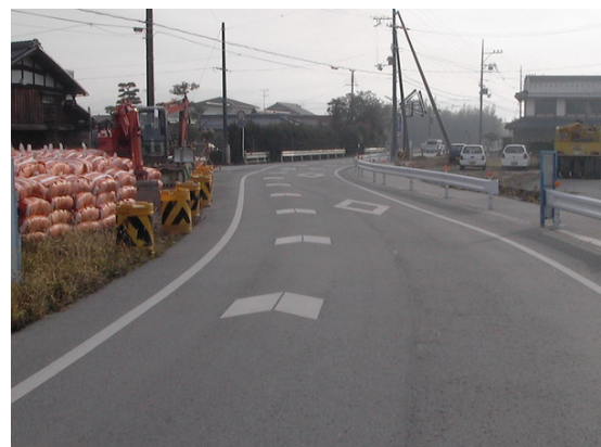
図-15 施工前の道路状況
