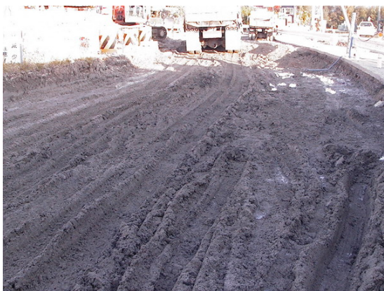
図-16 施工前の地盤状況
