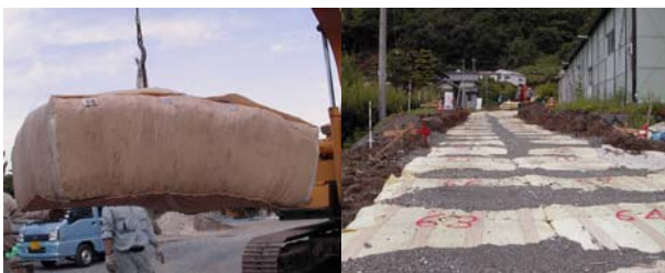
(a) 吊上げ状況 (b) 設置例
