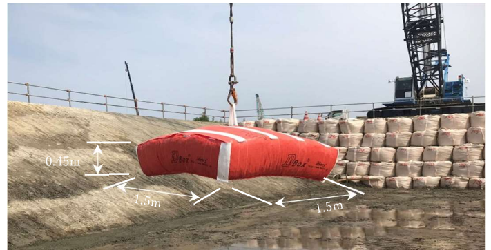
D・Box LS150(1m 3 重量2t)の吊り状況
