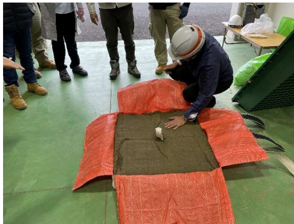
D・Box 転圧後の中詰状況確認
